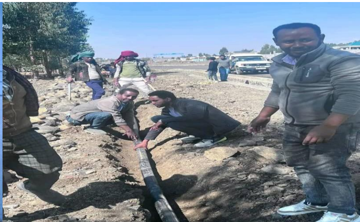
የሙሳሌ በህዝብ ተሳትፎ የተሰራ የውሃ መስመር ዝርጋታ
