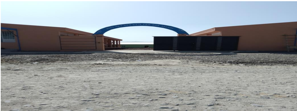
ምስል 11:- በህብረተሰብ ተሳትፎ የተገነባ የልቼ ቀበሌ አስተዳደር ፅ/ቤት ቢሮና መንገድ ግንባታ
